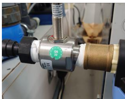
Figura 8. Traductor de debit plasat pe traseul aducțiunii de apă purificată.
