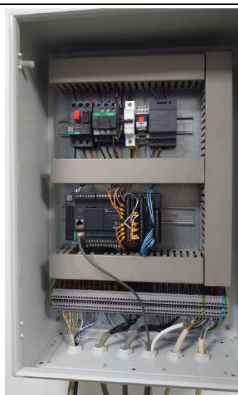
Figura 16. Componentele montate într-un dulap de protecție.
