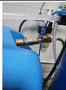
Figura 13. Traductor de debit montat pe traseele de dozare a reactivilor chimici.
