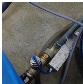
Figura 12. Senzor de presiune dotat cu modul de conversie tensiune - curent în regim de semnal unificat, amplasat pe diverse trasee de pompare.
