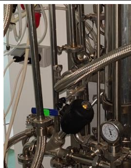
Figura 14. Vană comandată pneumatic, amplasată la capătul inferior al coloanei de filtrare tangențială.
