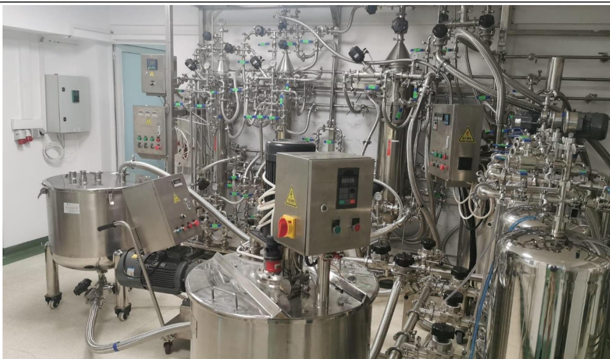
Figura 13. Imagine a modulelor de filtrare și purificare în regim de diafiltrare a soluțiilor coloidale de collagen „extras” utilizând instalația pilot automatizată a companiei Sanimed, module dotate cu componentele instalației de automatizare dezvoltată prin proiect.
